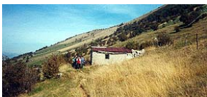
Veduta della baita dall'esterno in località Prai
